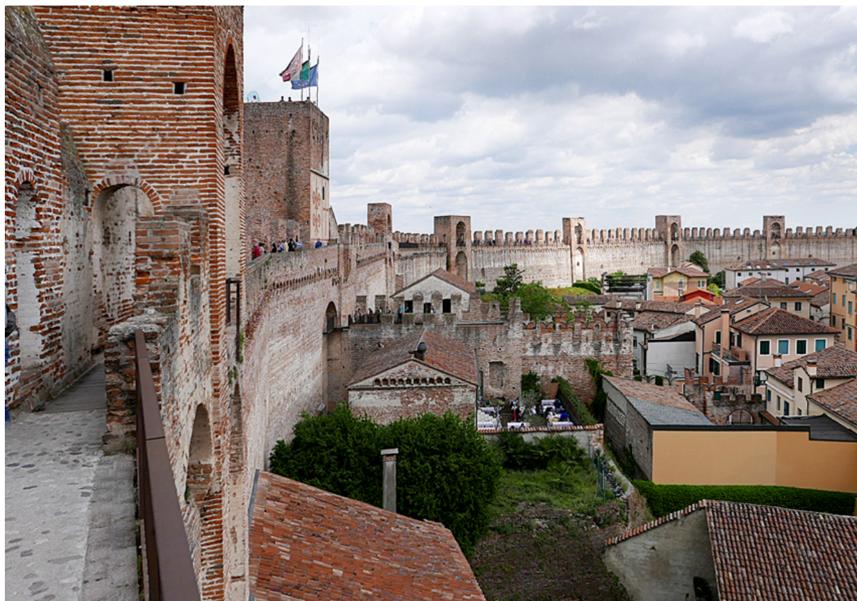
Cittadella (Pd), Cinta muraria, camminamento di ronda.
