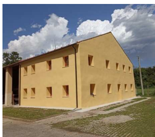
La sede di Montecchio Precalcino ristrutturata
