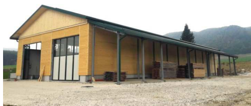
Il nuovo capannone falegnameria in Cansiglio
