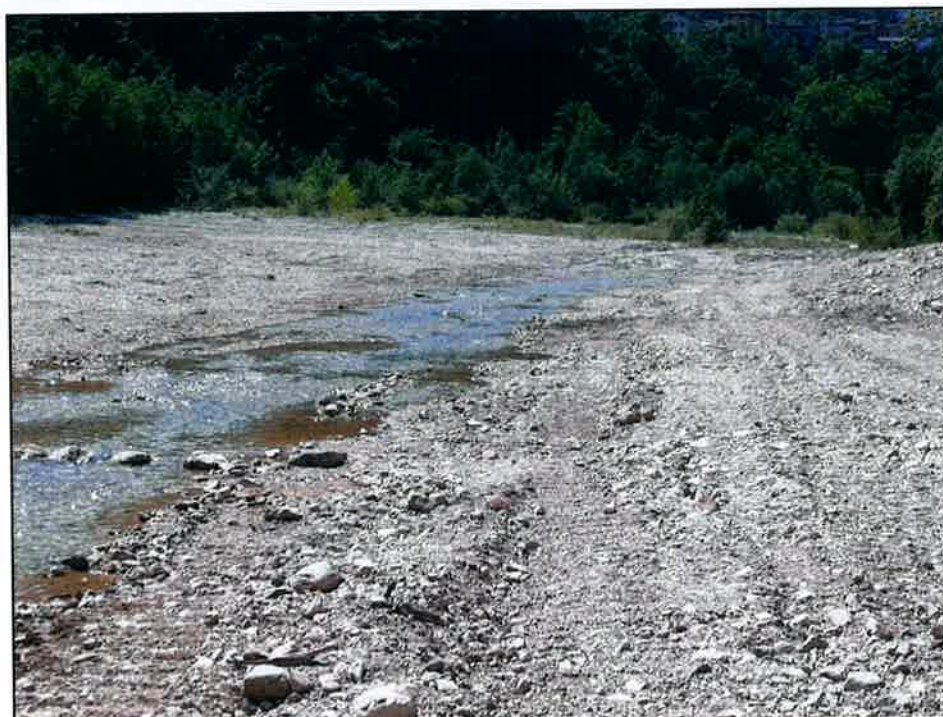
Figura 1: stato fine lavori prima tranche
