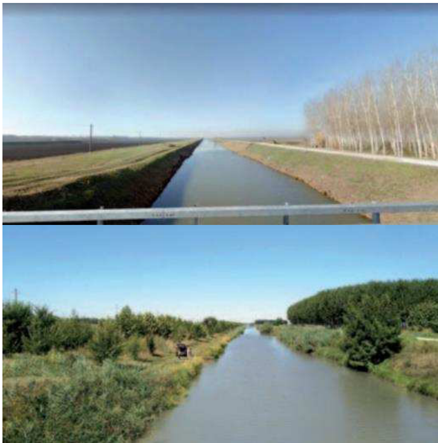
Figura 288. Allargamento di sezione mediante creazione di banchine allagabili. La figura rappresenta lo scenario ante (in alto) e post operam (in basso).
