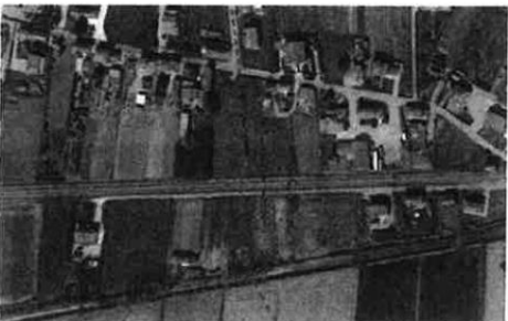
Figura 3-10 – Attraversamento linea ferroviaria Legnago-Rovigo
