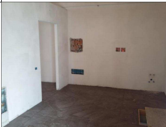
Foto 6: primo piano: zona impiattamento collegata con la cucina tramite apposito montacarichi.
