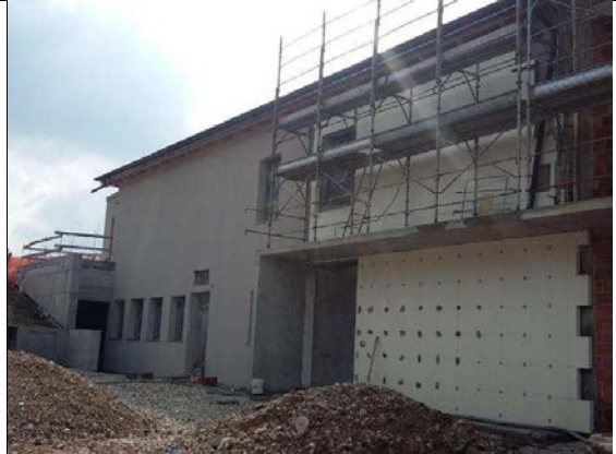
Foto 2: facciata nord nuovo stabile interamente finanziato dalla Provincia di Vicenza
