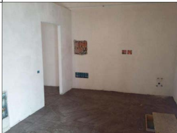
Foto 6: primo piano: zona impiattamento collegata con la cucina tramite apposito montacarichi.
