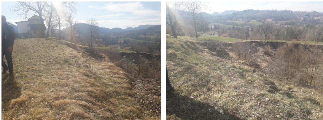
Fig.4 – Particolare della zona di coronamento (evento 2014) e della vicina abitazione. Sopralluogo 2019.
