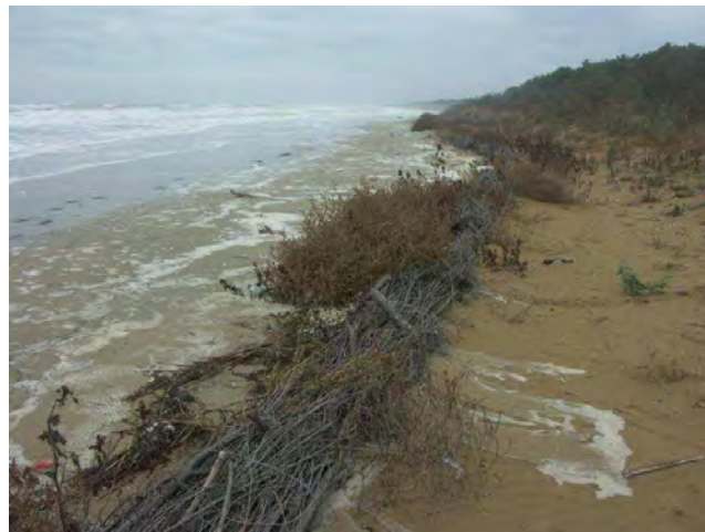
Resistenza alle mareggiate e spontanea formazione di habitat di duna embrionale su fascinate a protezione del piede delle dune bianche
