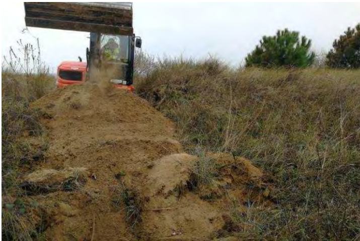
Operazioni di chiusura di un varco
