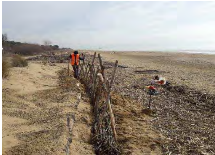
Operazioni di posa e fissaggio di fascinata all'interno del solco a protezione del piede della duna
