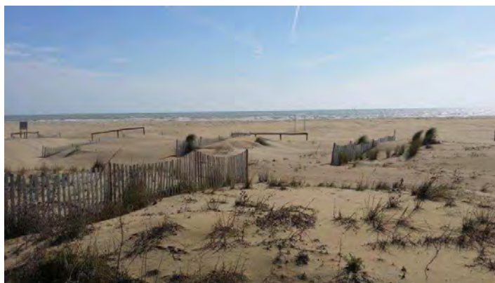
Frangivento in paleria e stecche di legno per favorire il naturale accumulo di sabbia
