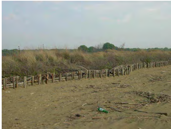
Palificata a protezione del piede delle dune in zona con forte erosione
