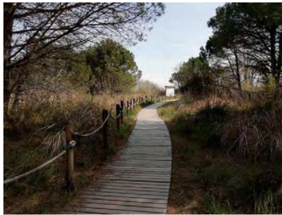
Progetto e realizzazione di camminamento in tavolato di legno appoggiato
