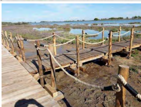
Progetto e realizzazione di passerella rialzata e staccionata con pali e corda continua
