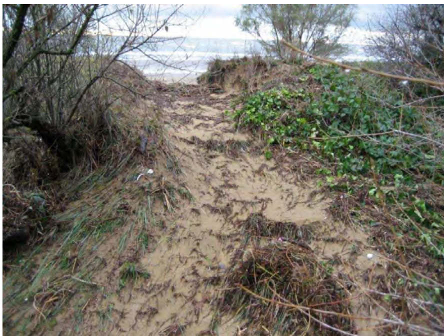
Figura 24. Un esempio di "blowout" sulle dune del litorale di Vallevecchia: il prolungato calpestio ha provocato l'interruzione del cordone dunale e l'apertura di un varco, attraverso il quale l'acqua è penetrata verso l'entroterra.
