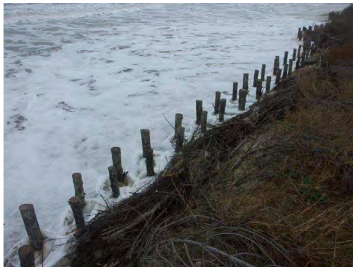
Resistenza alle onde durante una mareggiata di una palificata
