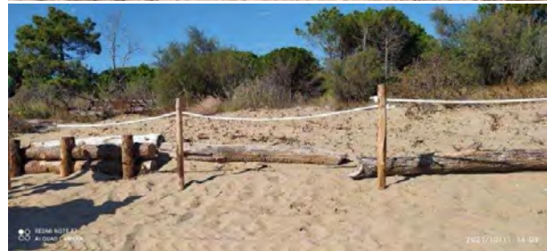
Progetto e realizzazione palizzata con staccionata di rinforzo (Vallevecchia, Caorle)
