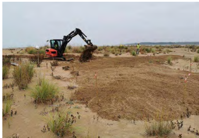
Operazioni di disposizione sabbia e prima profilatura di nuovi apparati dunali di diversa entità
