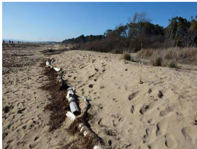
Disposizione di tronchi e materiale vegetale spiaggiato a protezione del piede di una duna
