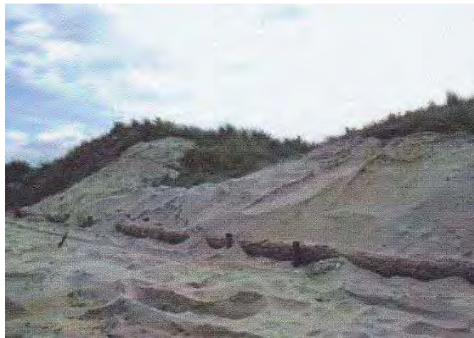
Formazione dei gradoni per la creazione di nuovi apparati dunali con la tecnica della palizzata semplice e successiva ricopritura a renderla impercettibile
