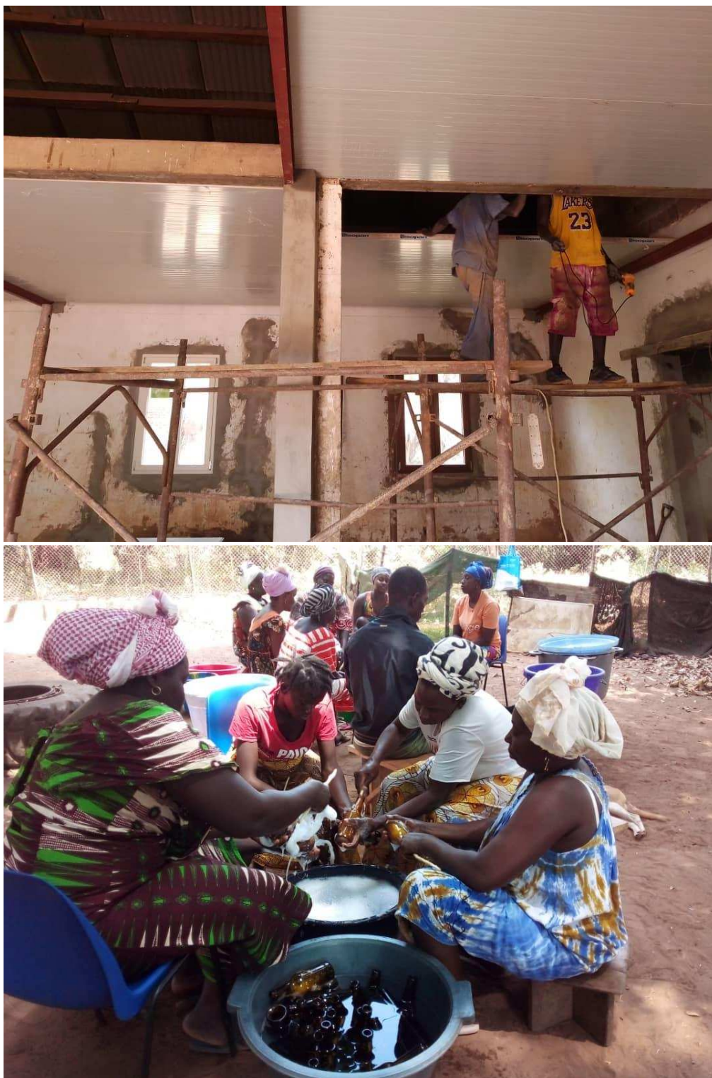
Realizzazione del laboratorio di trasformazione della frutta, e formazione alle donne del villaggio di Binintida". Progetto "Spazio Donne" a San Francisco da Floresta in Guinea Bissau realizzato dalla Onlus "Crescere insieme" di Verona (Piano regionale 2021)
