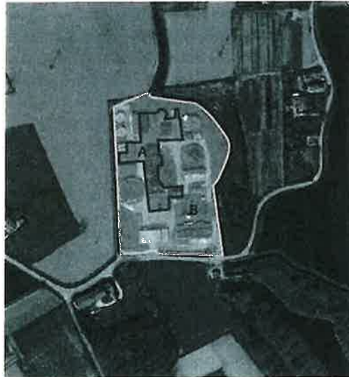
Area dell'impianto: A: piattaforma trattamento rifiuti; B: depuratore acque reflue
