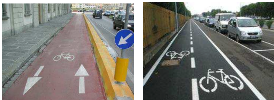
Figura 6.13 Esempi di piste ciclabili realizzate su sede stradale o su sede propria, separate dalla carreggiata stradale.
