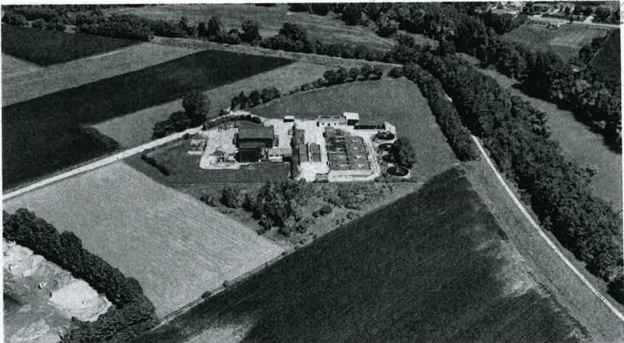
Figura 13. Impianto esistente, ambito di localizzazione
