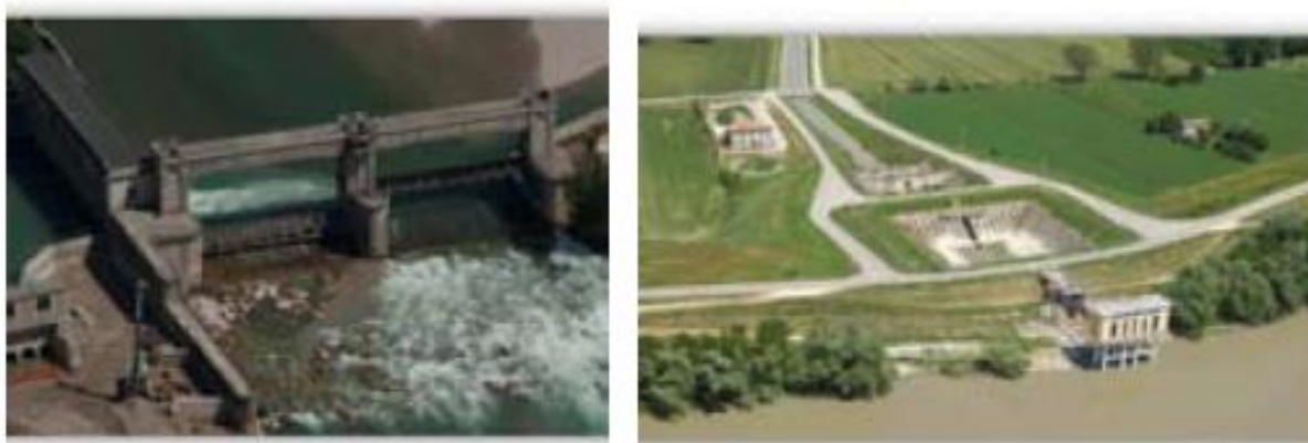
Figura 14 Opera di presa dal fiume Piave a Fener; Opera di presa dal fiume Po a Calto
