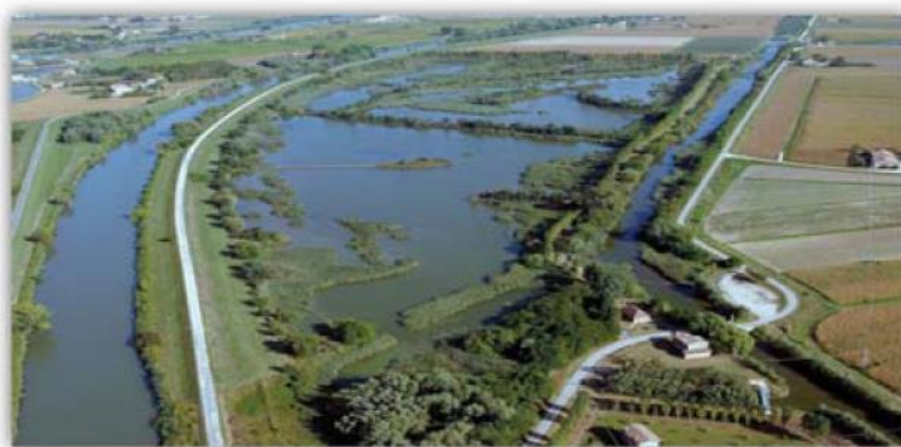
Bacino di fitodepurazione di Ca' di Mezzo di Codevigo (PD)
