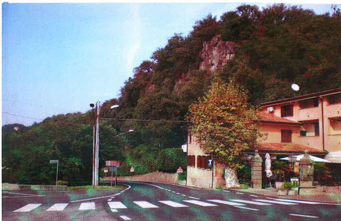
Foto 1: vista verso nord-ovest dell'area interessata dalla variante, subito dopo l'edificio in primo piano sulla destra.
