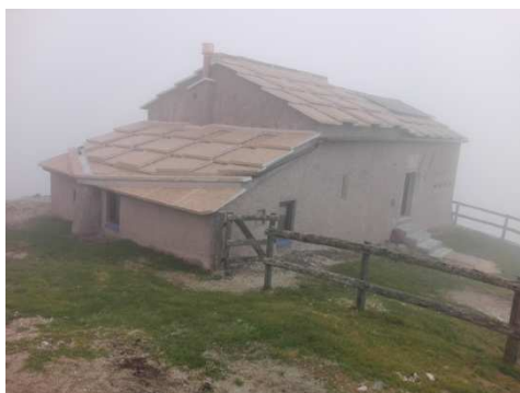
Malga Fraselle di Sopra al termine della ristrutturazione (foto del 4 ottobre 2023)
