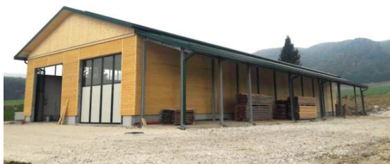
Il nuovo capannone falegnameria in Cansiglio
