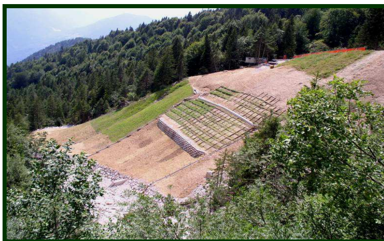
Opere di consolidamento versante in frana
