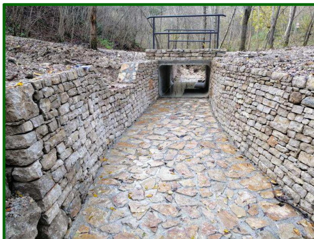
Cunettone in calcestruzzo rivestito in pietrame
