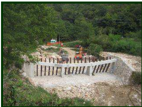
Briglia filtrante in calcestruzzo e gradinata di briglie
