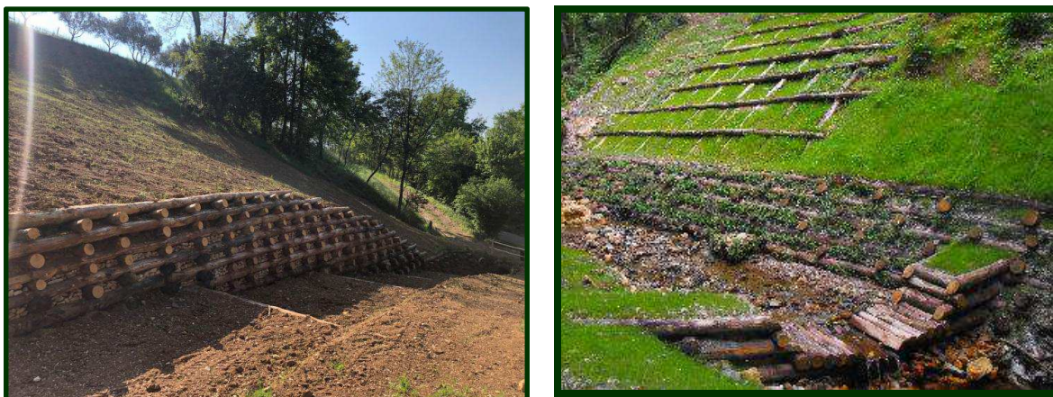
Opere trasversali e longitudinali realizzate con tecniche di ingegneria naturalistica per il consolidamento del fondo dell'alveo e difesa di sponda
