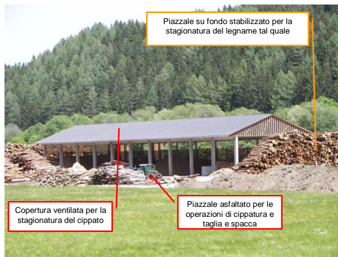
Esempio di layout di una piazzola attrezzata per biomassa legnosa (V. Francescato - AIEL)
