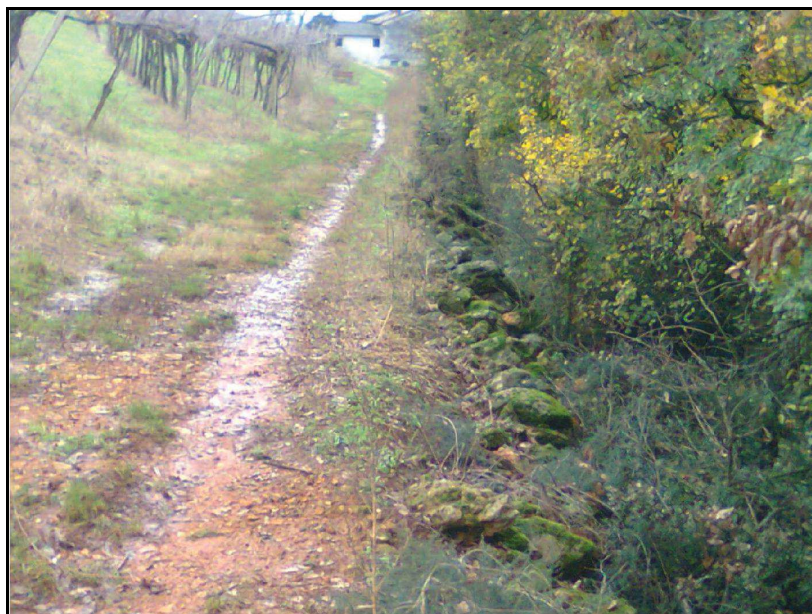
Fig. 7 – Muretto a secco lungo la scarpata di degradazione.
