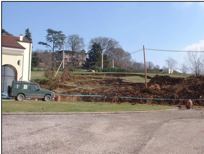
Fig. 1 – Fenomeno franoso visto dal piazzale antistante la struttura ricettiva.
