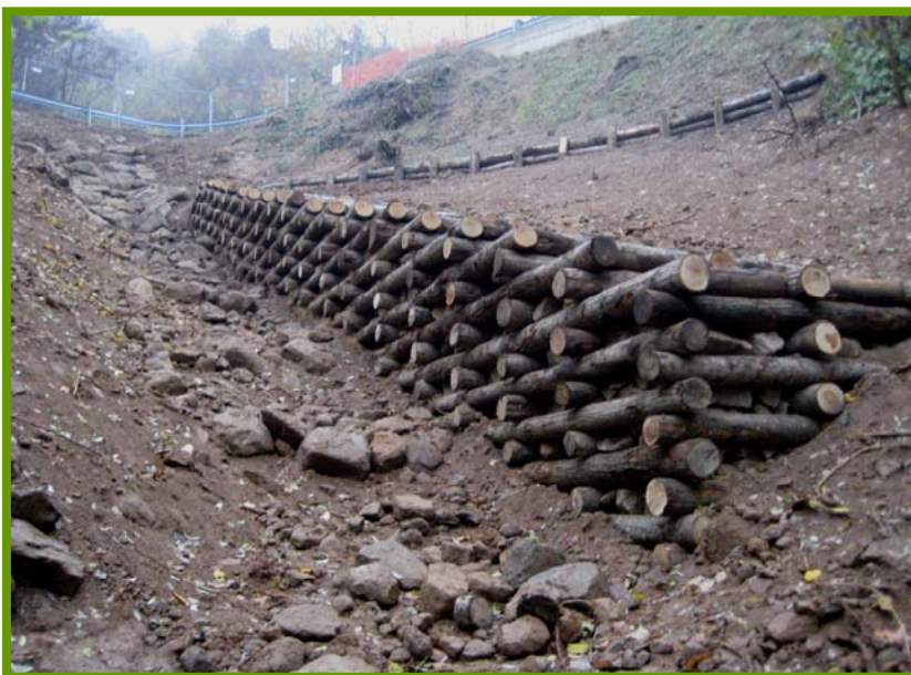
Stabilizzazione versante in frana (S.F.R. di Padova e Rovigo)
