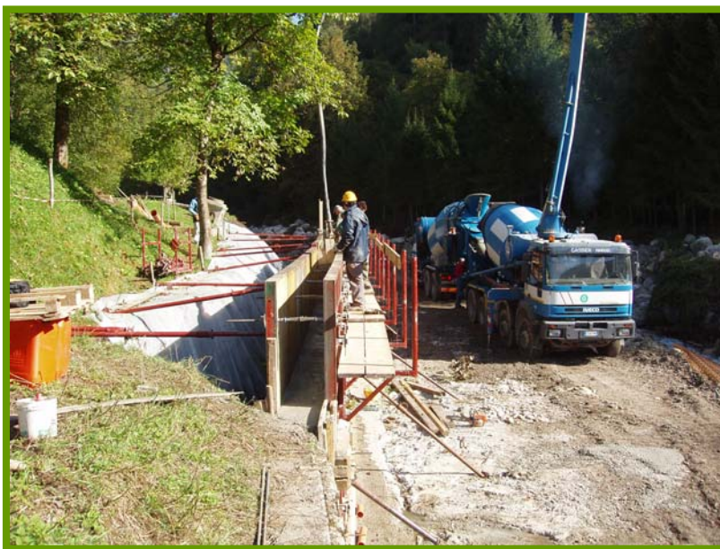
Costruzione muro di sostegno in cls armato (S.F.R. di Belluno)
