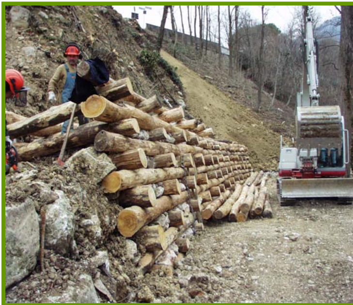
Realizzazione arcia in legname e pietrame (S.F.R. di Belluno)
