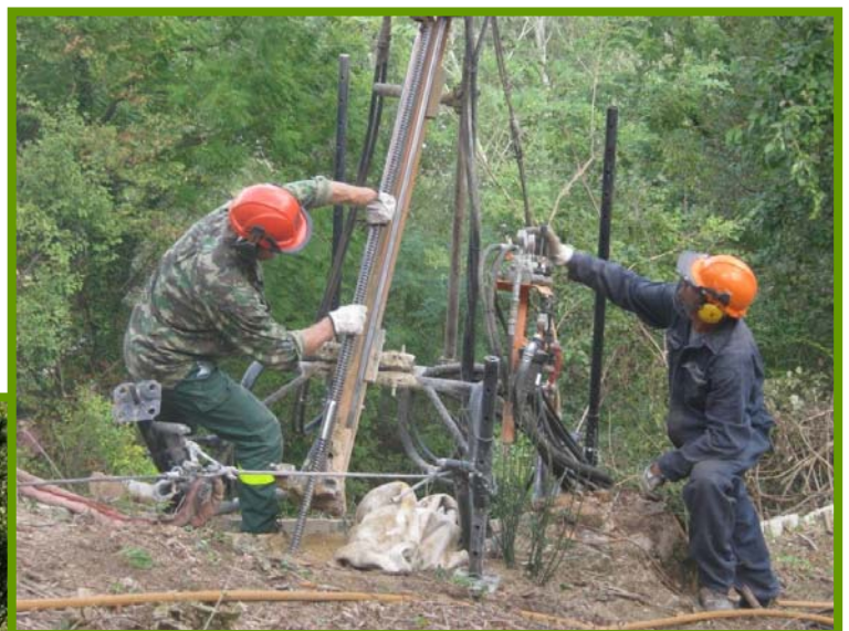
Attività di perforazione nella realizzazione di opere trasversali in massi ciclopici (S.F.R. di Belluno)
