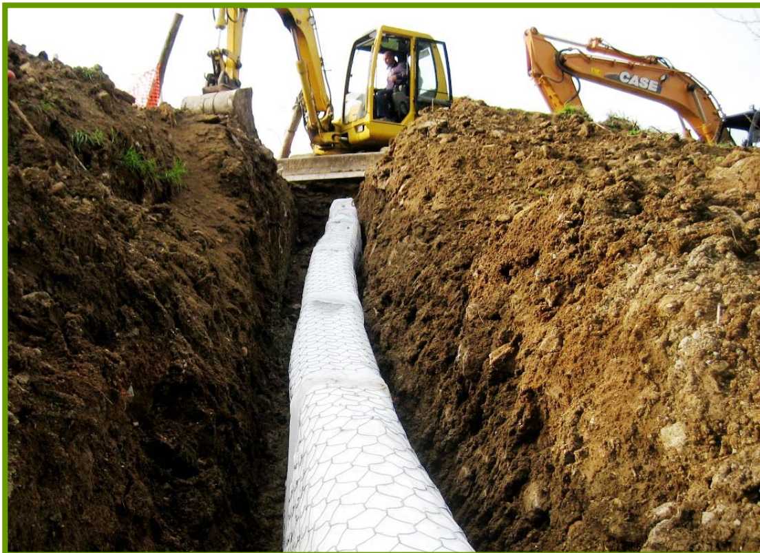
Realizzazione drenaggi su versante in frana (S.F.R. di Padova e Rovigo)
