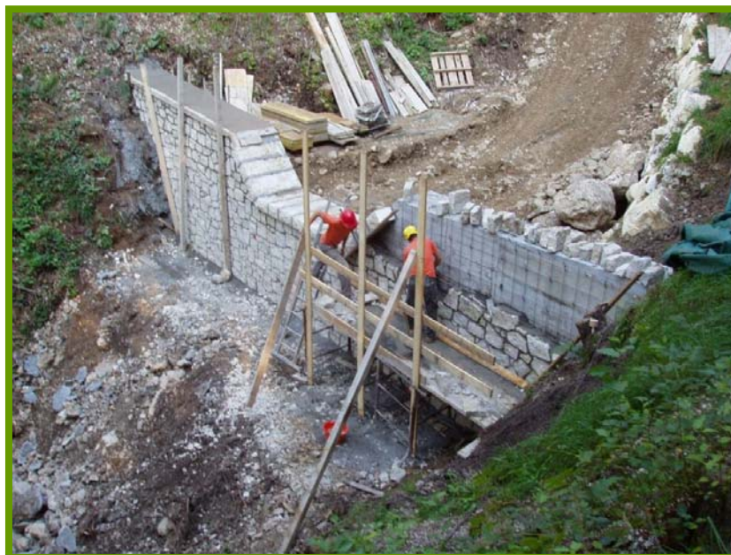
Realizzazione di briglia in calcestruzzo armato, rivestita (S.F.R. di Belluno)
