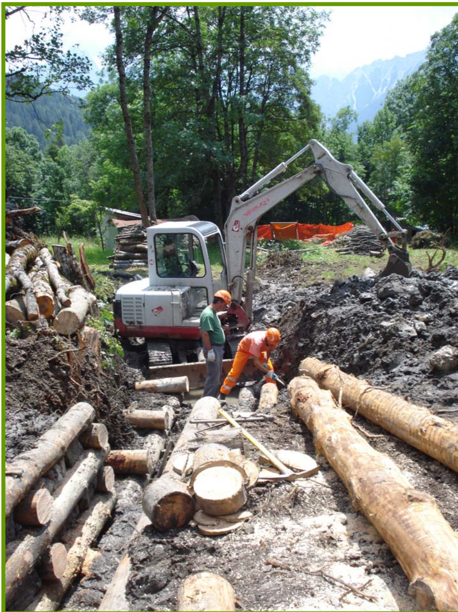
Canalizzazione in legname e pietrame (S.F.R. di Belluno)
