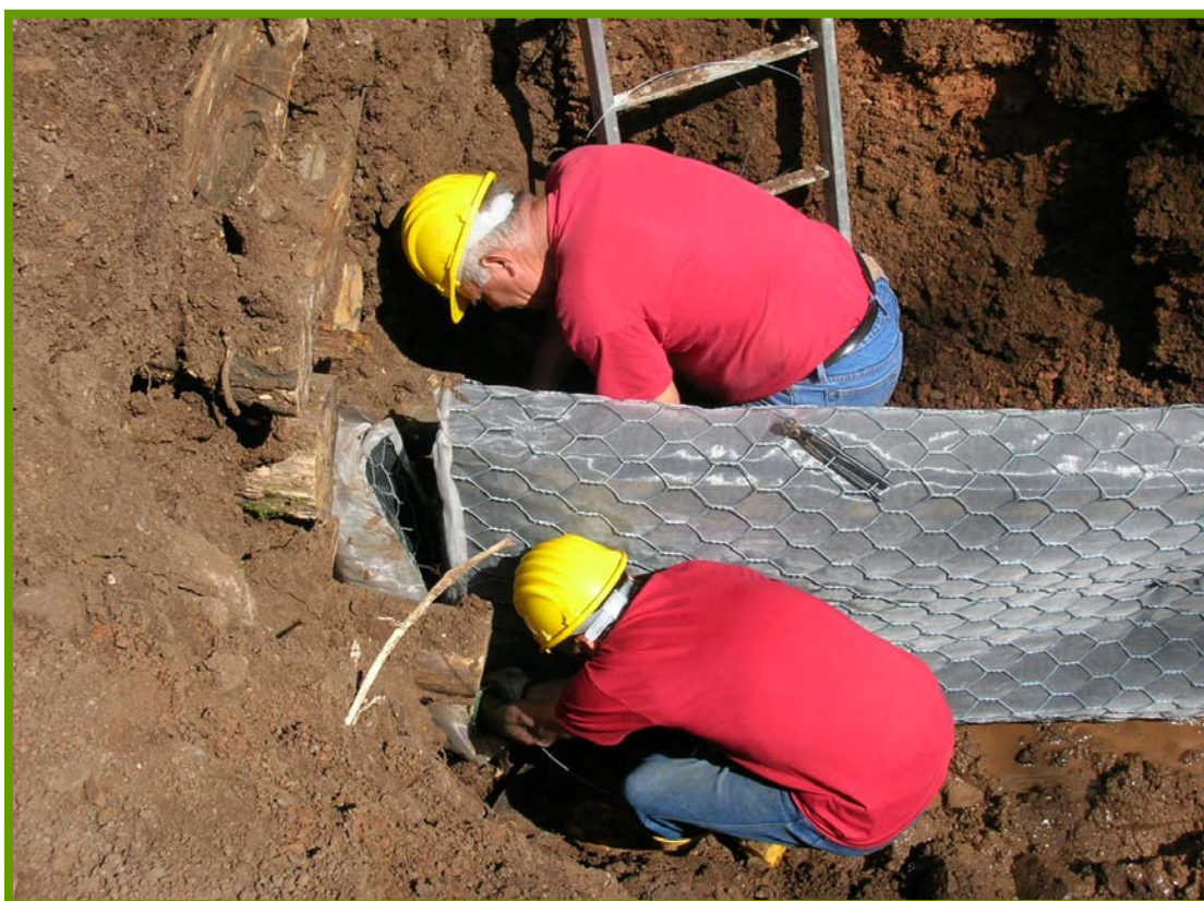
Posa di drenaggi superficiali su versante in frana (S.F.R. di Verona)
