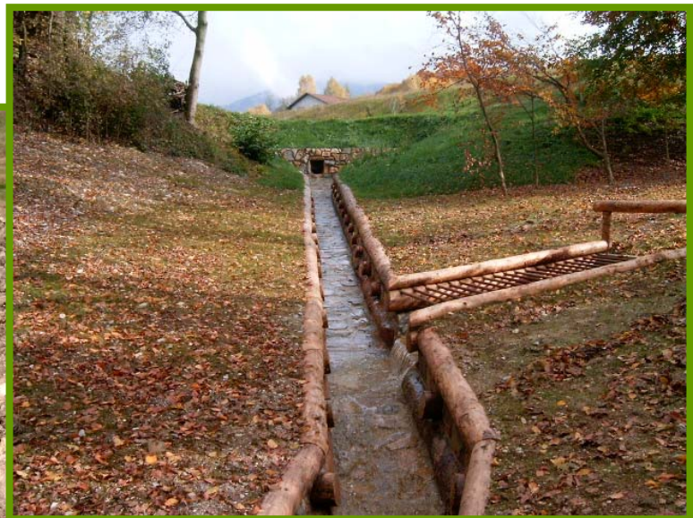
Reti drenanti in fase di realizzazione e ad intervento ultimato (S.F.R. di Belluno)
