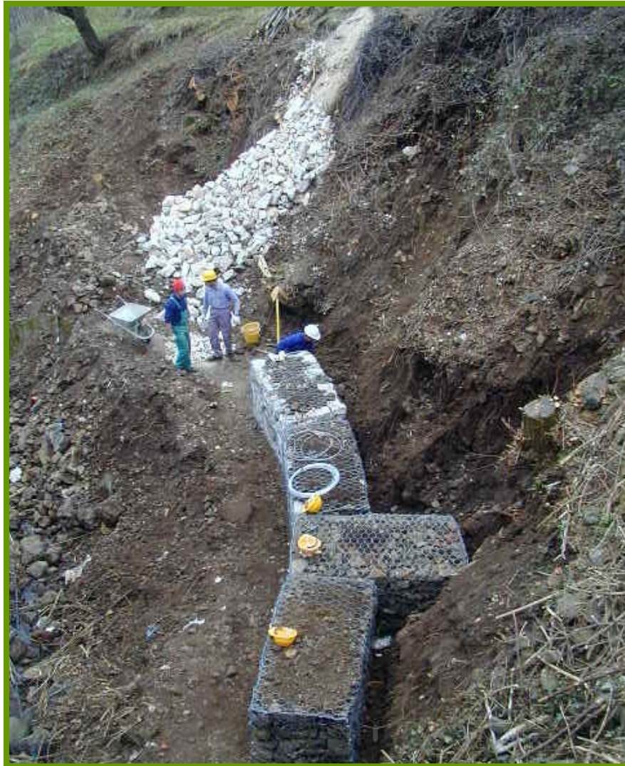
Sistemazione longitudinale di sponda in massi legati (S.F.R. di Verona)
