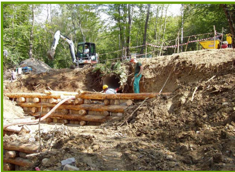
Cantiere di sistemazione e sostegno a viabilità silvo-pastorale (S.F.R. di Belluno)
