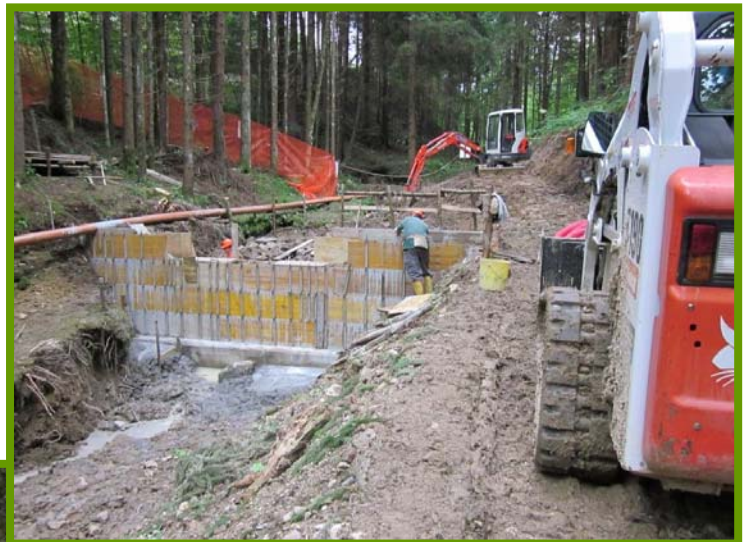
Realizzazione briglie in calcestruzzo (S.F.R. di Belluno)
