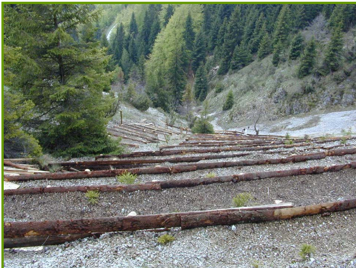
Sistemazione di versante con materiale vivo (S.F.R. di Vicenza)
