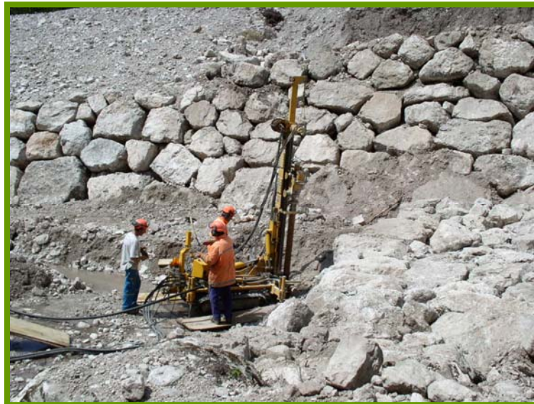
Attività di perforazione nella realizzazione di opere trasversali in massi ciclopici (S.F.R. di Belluno)
