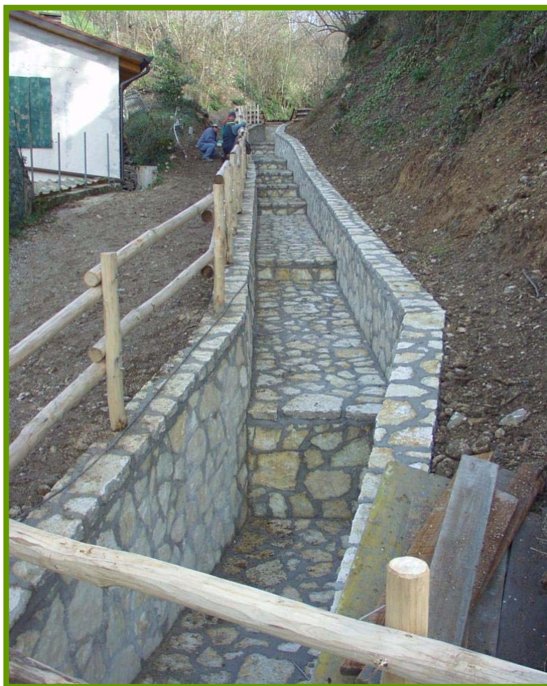
Realizzazione di cunettone di raccolta e smaltimento acque (S.F.R. di Treviso e Venezia)
