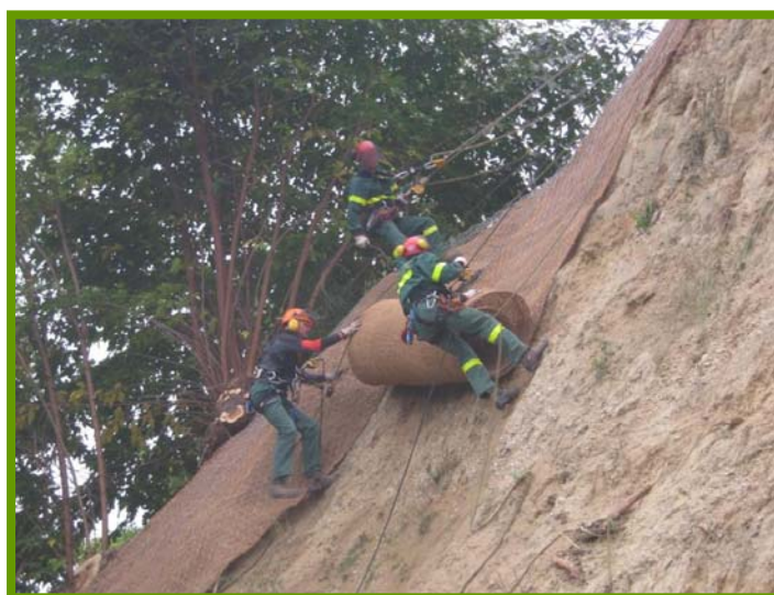
Sistemazione versante in frana (S.F.R. di Treviso e Venezia)
