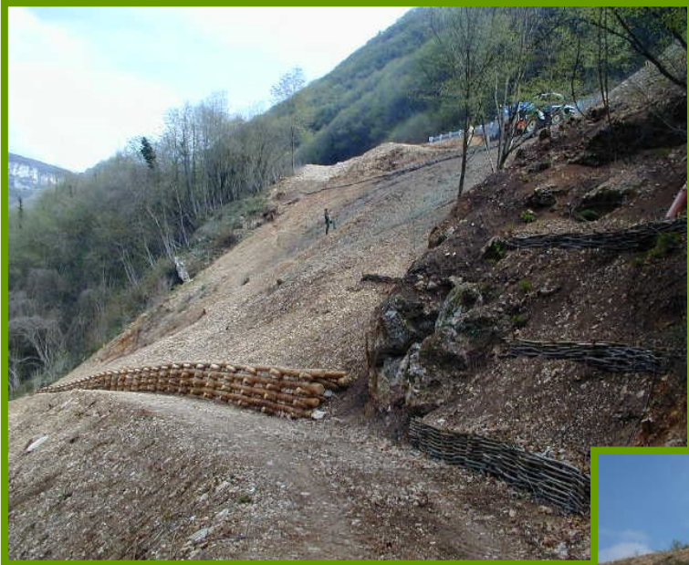
Consolidamento e ricomposizione di pendici in frana (S.F.R. di Verona)
