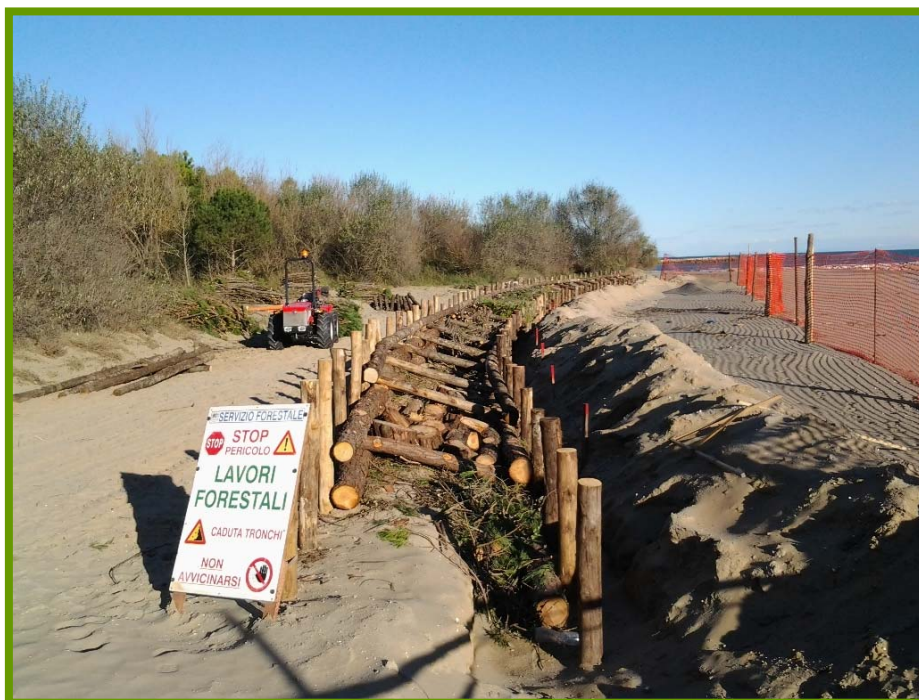
Intervento di ricostituzione e consolidamento dunoso litoraneo (S.F.R. di Treviso e Venezia)
