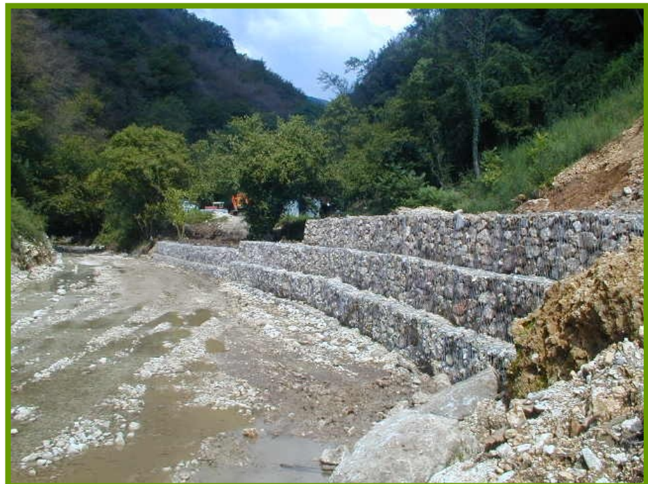
Sistemazione longitudinale in gabbioni (S.F.R. di Belluno)
