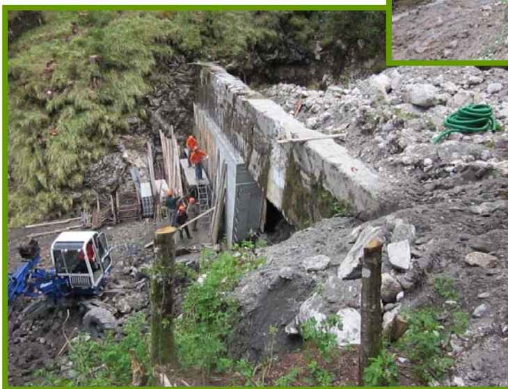
Intervento di consolidamento e sottofondazione (S.F.R. di Belluno)
