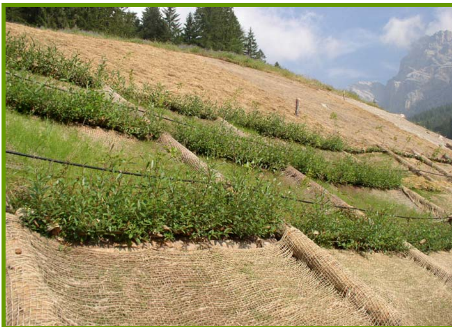
Grata viva in sistemazione di versante (S.F.R. di Belluno)
