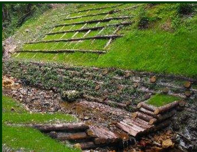
**Opere trasversali e longitudinali realizzate con tecniche di ingegneria naturalistica per il consolidamento del fondo dell'alveo e difesa di sponda**
