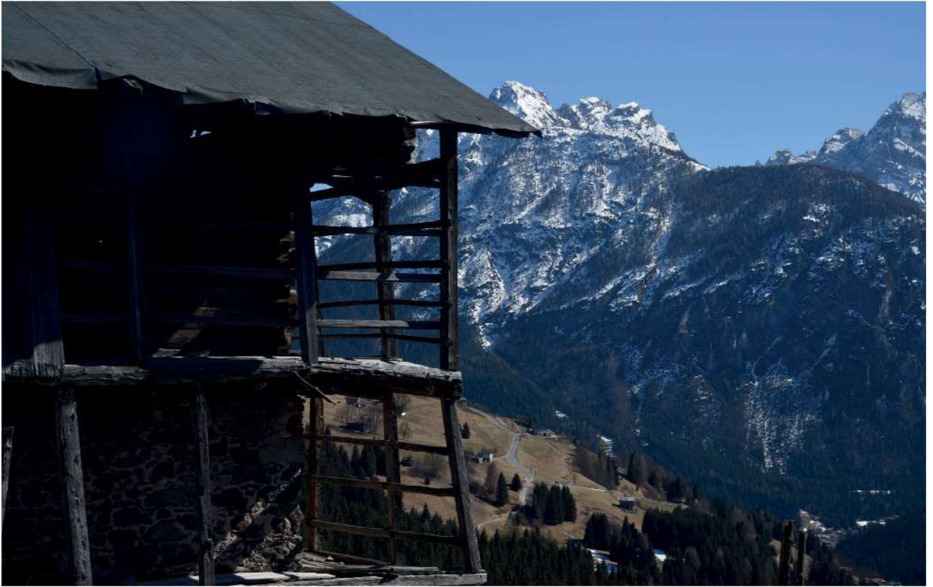
50. Tabià nella frazione di Costa (S. Nicolò di Comelico).
