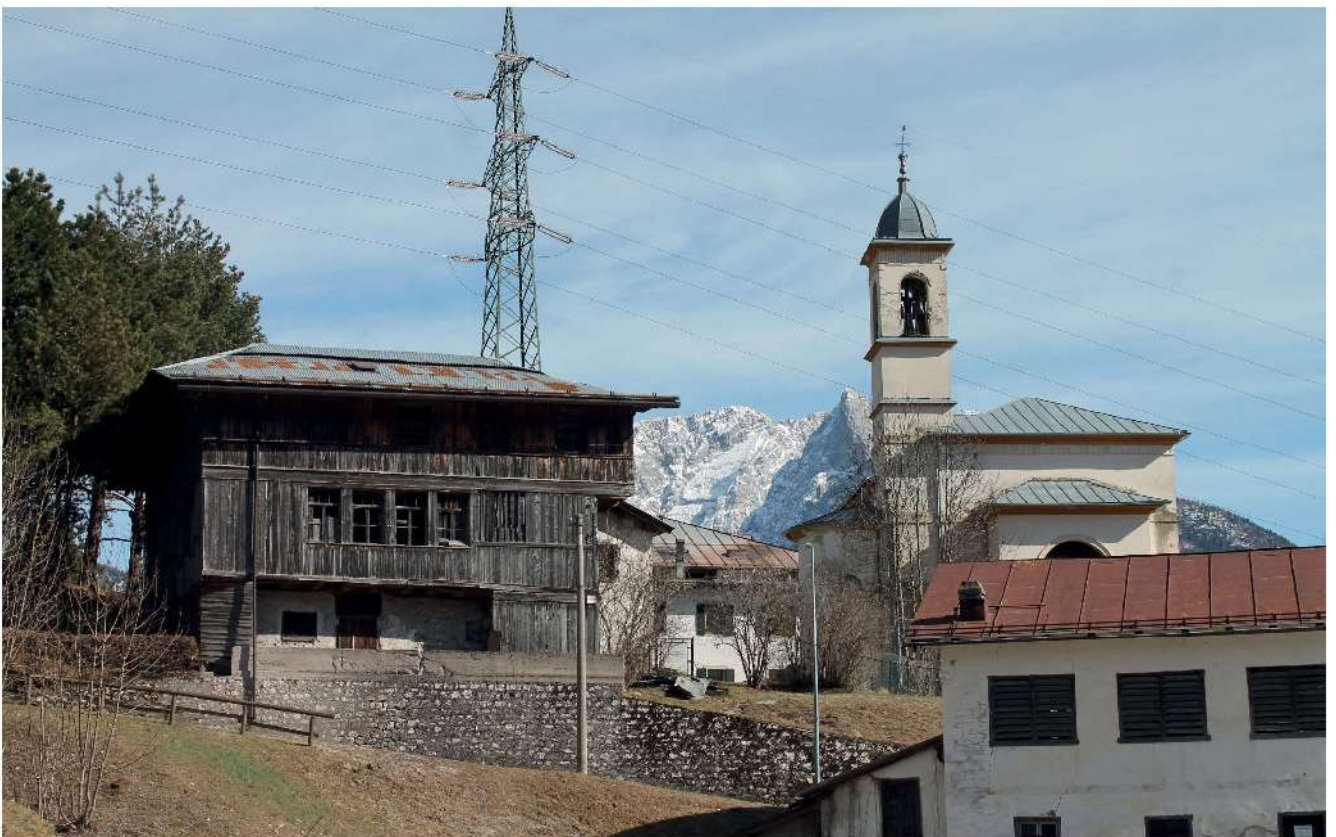
55. Auronzo, esempio di abitazione tradizionale in legno.
