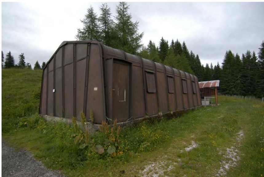
IL PREFABBRICATO METALLICO UTILIZZATO COME RICOVERO PER L'ALPEGGIO
