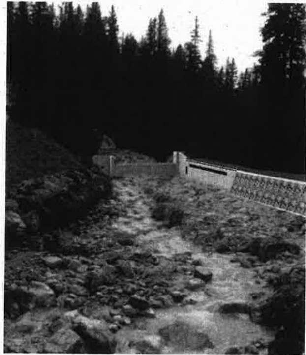
Figura n. 3_ Fotoinserimento dell'opera di presa, particolare
