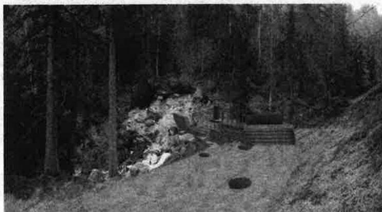
Sito opera di presa da accesso (post operam)
