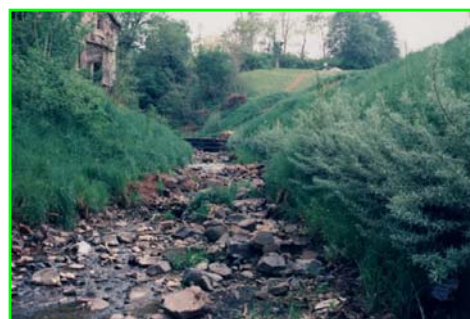
Esempi di difese spondali flessibili, in pietrame e in pietrame con inserimento di talee
