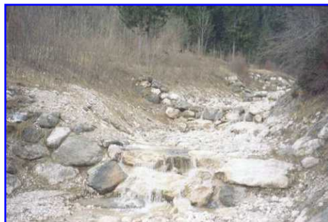
Esempi di difese spondali flessibili, in pietrame e in pietrame con inserimento di talee
