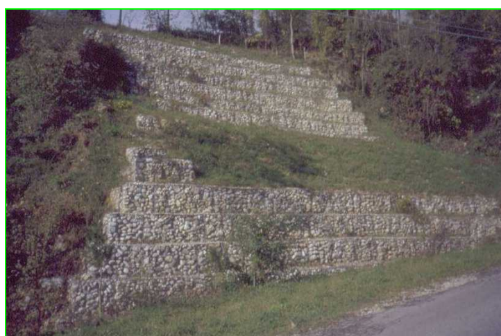
Esempio di gabbionate a sostegno di aree in frana
