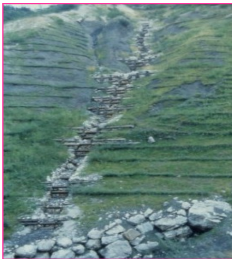
Esempio di frana consolidata con l'impiego di fascinate
