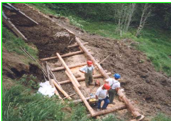
Esempio di arcie a sostegno di versanti in frana durante l'esecuzione dei lavori e a conclusione dell'opera
