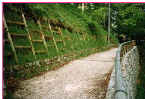
Esempio di grate vive durante e dopo l'intervento
