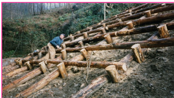
Esempio di grate vive durante e dopo l'intervento
