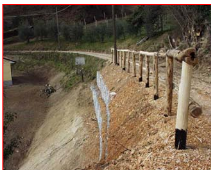
Esempio di gabbionate a sostegno di scarpate a monte e a valle della viabilità
