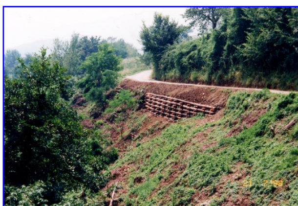
Esempio di arcie a sostegno di versanti in frana durante l'esecuzione dei lavori e a conclusione dell'opera
